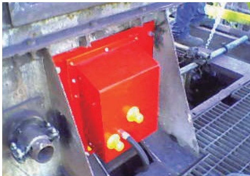
Arcelormittal - Tubarão - ES
